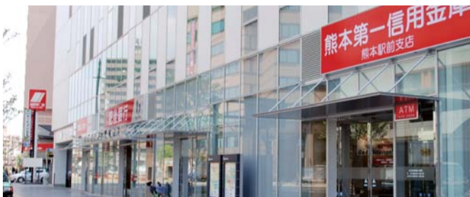
▲電車通り沿いには肥後銀行、熊本第一信用金庫、ニッポンレンタカーが入居
